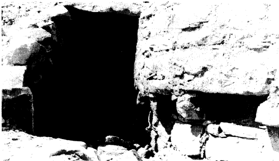
Foto 5. Corta galería ubicada en el flanco externo de la esquina curvada noroeste.
