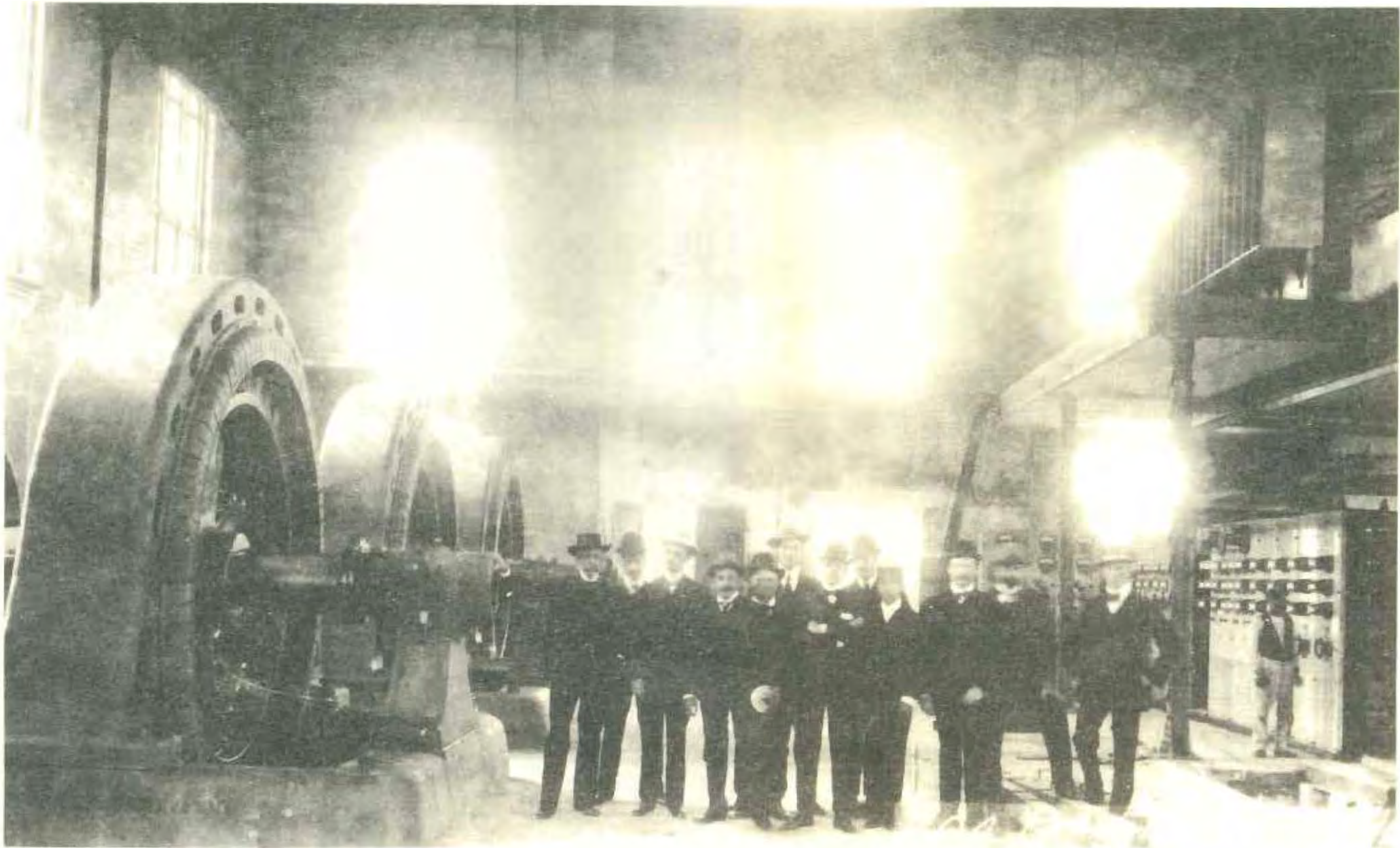
Paranaíba, mayo 14 de 1901. Visita a las obras de instalación de generadores General Electric Company. Entre el grupo de visitantes se encuentran, de izquierda a derecha, el tercero es Frederick S. Pearson y el sexto, atrás, Alexander Mackenzie. Fotografía: Departamento Patrimônio Histórico/Eletropaulo.
